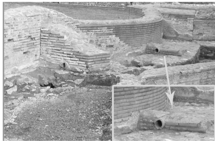
Ambiente di servizio delle terme - particolare di tubuli rotondi
