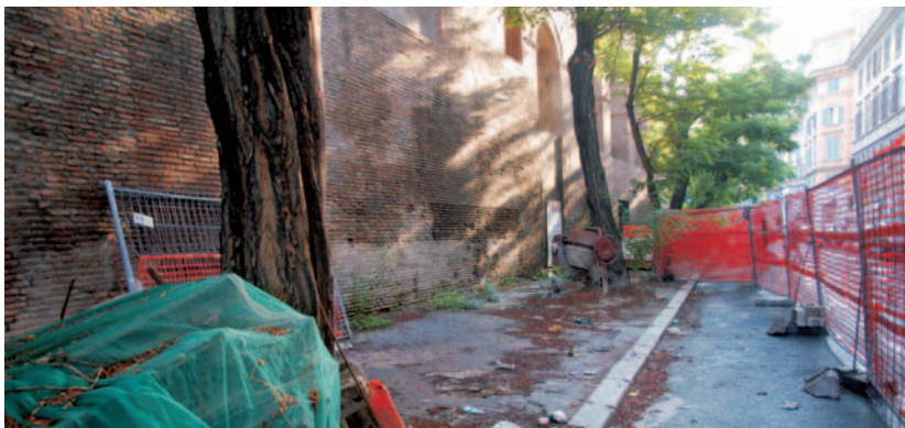
Mura aureliane di Via Campana - Lavori iniziati nel 2008
