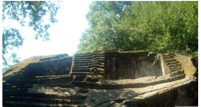
Le due grandi vasche, separate dalla gradinata centrale. Si vedono anche le nicchie, i verosimili sistemi di canalizzazione, le vaschette intagliate nella pietra e, all'estrema destra, è visibile la rampa di 9 scalini
