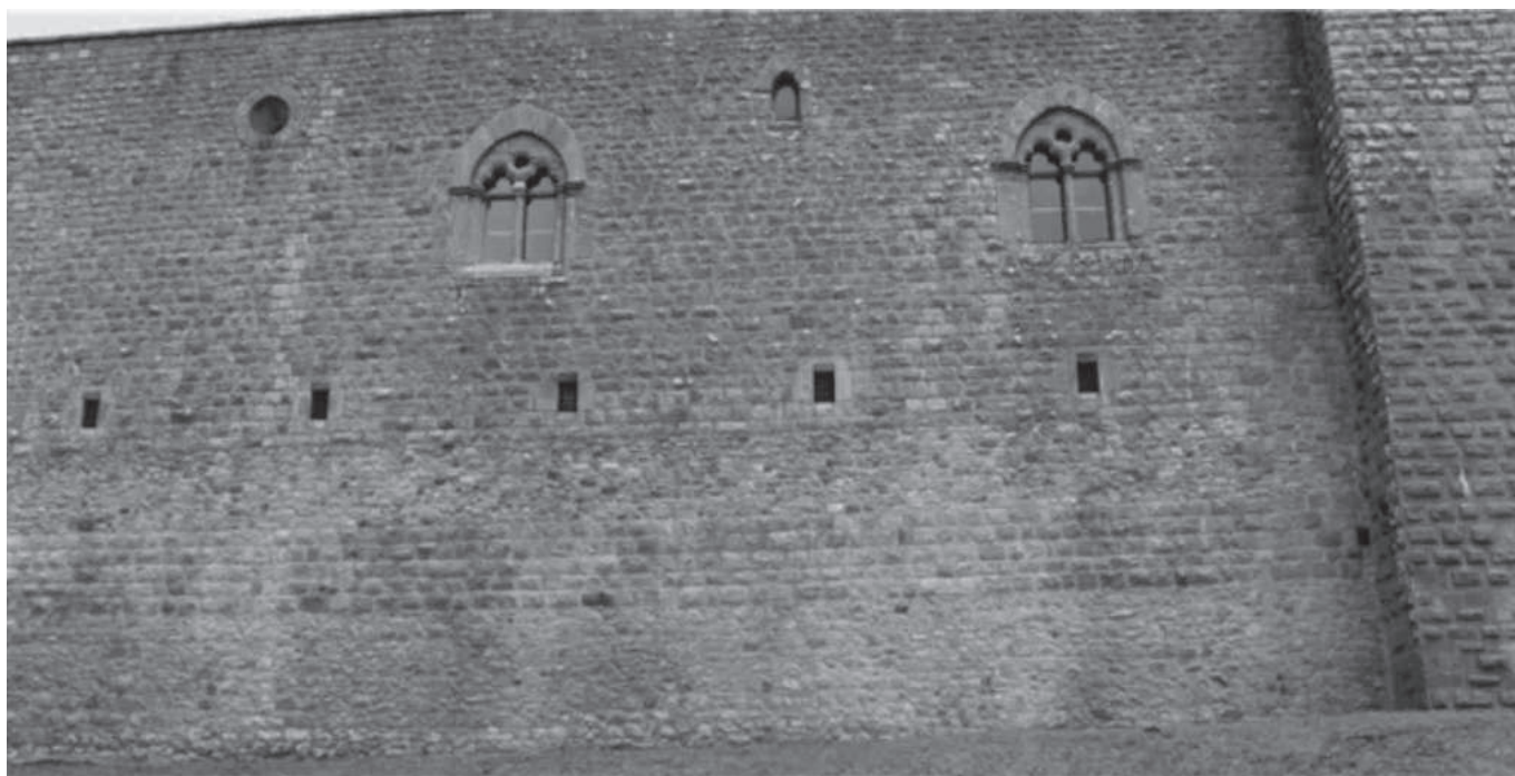
Fig. 15. Stratificazioni storiche delle murature (foto dell'autore)
